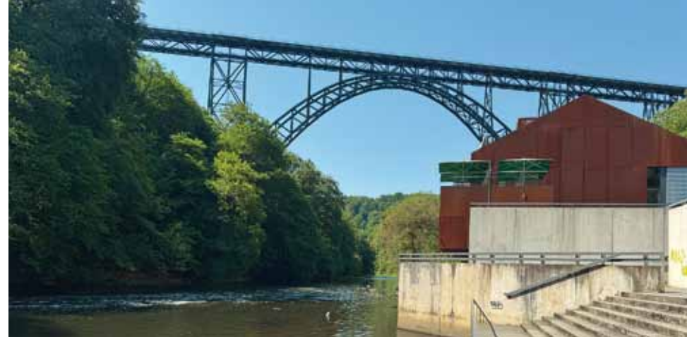
Die Müngstener Brücke – Wahrzeichen des Bergischen Landes und Ausgangspunkt der Reise durch die vier Elemente.
